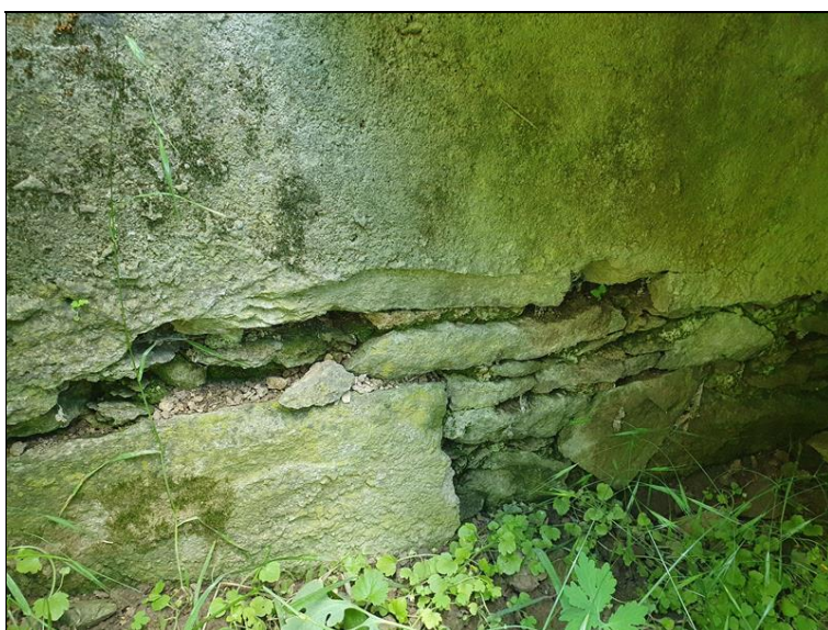
Porušené spárování u opěry
